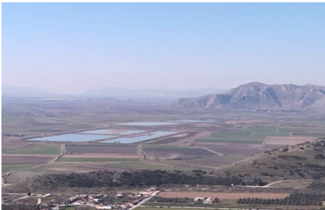
Εικόνα 2.6: Αρδευτικά, αποστραγγιστικά και έργα οδοποιίας στο αγρόκτημα αναδασμού Δήμητρας
